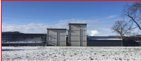
Umbau Spänesilo Industrie und Gewerbe, Dottikon
