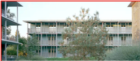
Neubau Mehrfamilienhaus Wohnen, Dottikon
