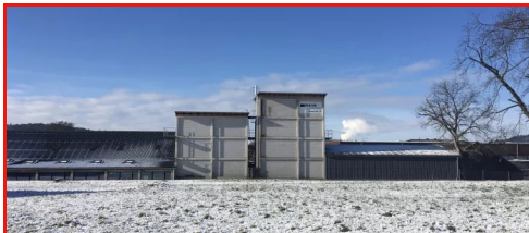
Umbau Spänesilo Industrie et artisanat, Dottikon
