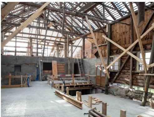
Le hangar à tabac et les combles de la maison pendant le chantier
