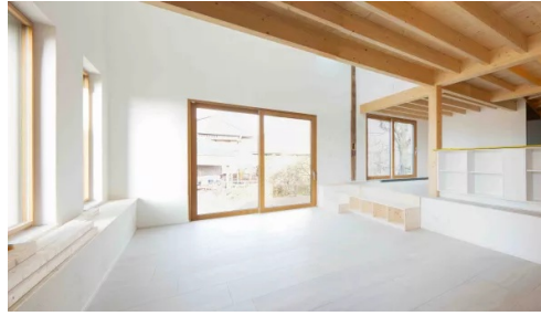
création d'un loft dans l'ancien hangar à tabac
