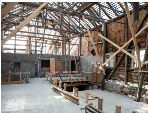
Le hangar à tabac et les combles de la maison pendant le chantier
